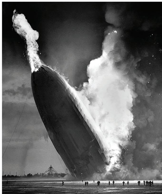
a studiare sistemi sicuri per impedirne l'accensione con scintille casuali o dovute a temporali. Sono state costruite molte paratie che dividono in 16 settori le varie parti contenenti i 200.000 m<sup>3</sup> di gas che ci permettono di volare stabilmente sino a 6.000 metri di altezza. Pensa che da quando il primo Zeppelin si è alzato dal suolo sono stati per-
